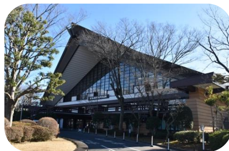
東日本技術研究所武道館
