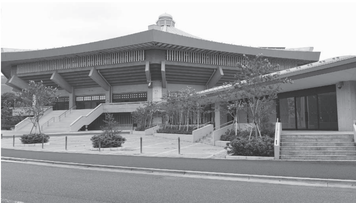
増改修工事が完了した日本武道館本館と中道場棟（右）
