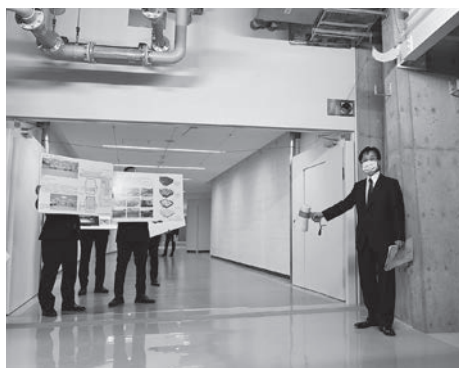
本館と中道場を結ぶ連絡通路
