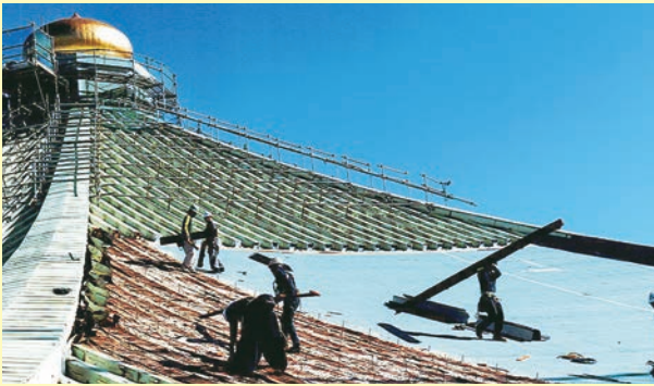
大屋根の葺き替え作業（© 山田新治郎）
