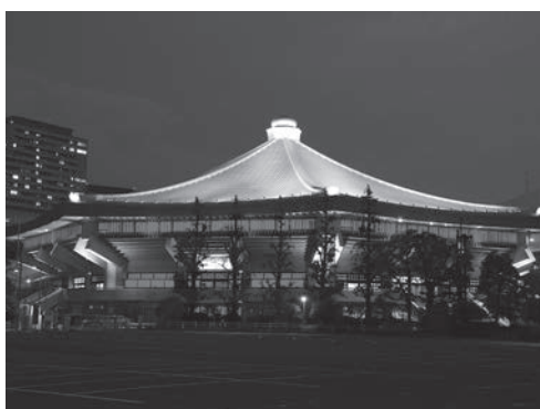
ライトアップされた本館（照明デザイン：石井幹子デザイン事務所）
